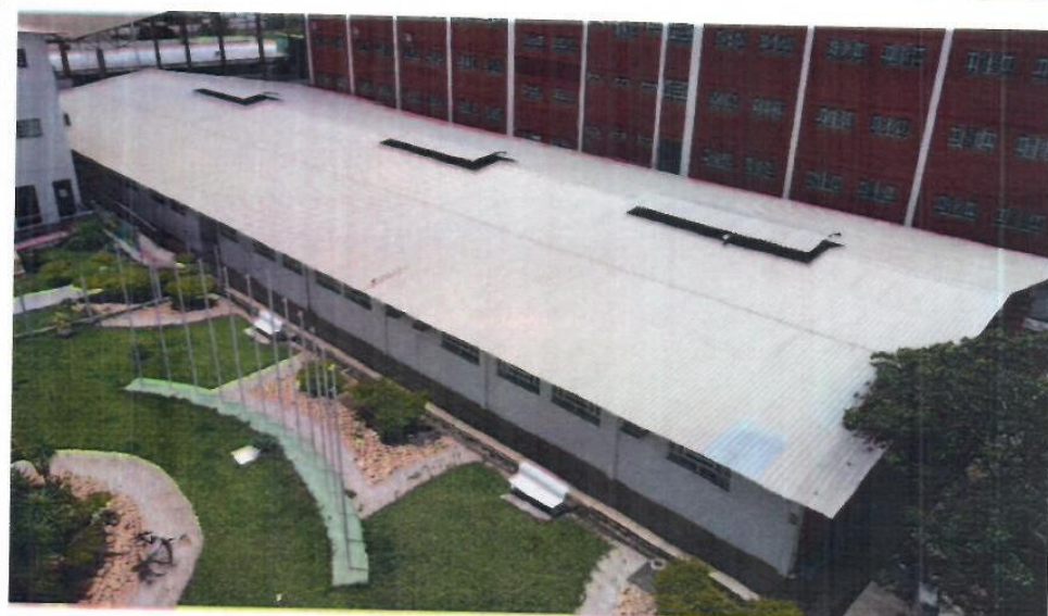
Vista Aérea Módulo 02 – Laboratórios (Imagem feita com Drone)
