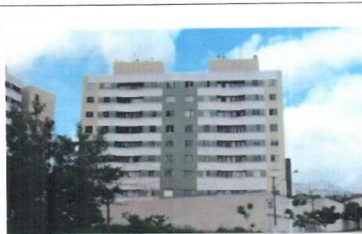
Vizinhança ao Imóvel – Edifício Residencial
