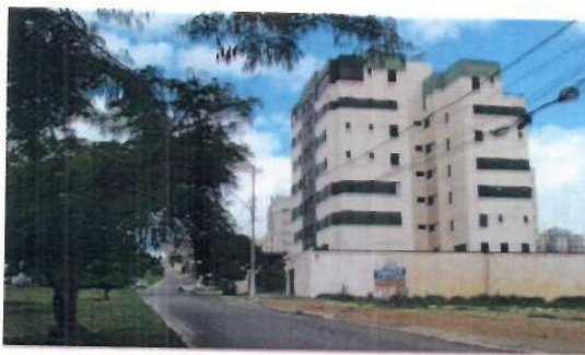
Vizinhança ao Imóvel – Edifícios Residenciais
