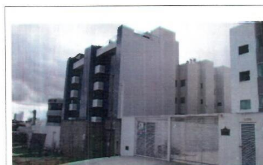
Vizinhança ao Imóvel – Edifícios Residenciais
