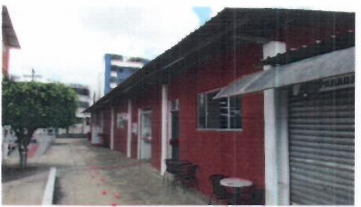
Biblioteca – Vista da Fachada
