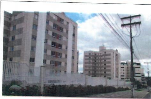
Vizinhança ao Imóvel – Edifícios Residenciais
