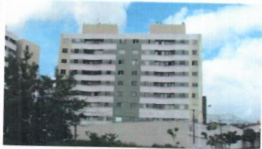
Vizinhança ao Imóvel – Edifícios Residenciais
