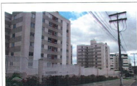
Vizinhança ao Imóvel – Edifícios Residenciais
