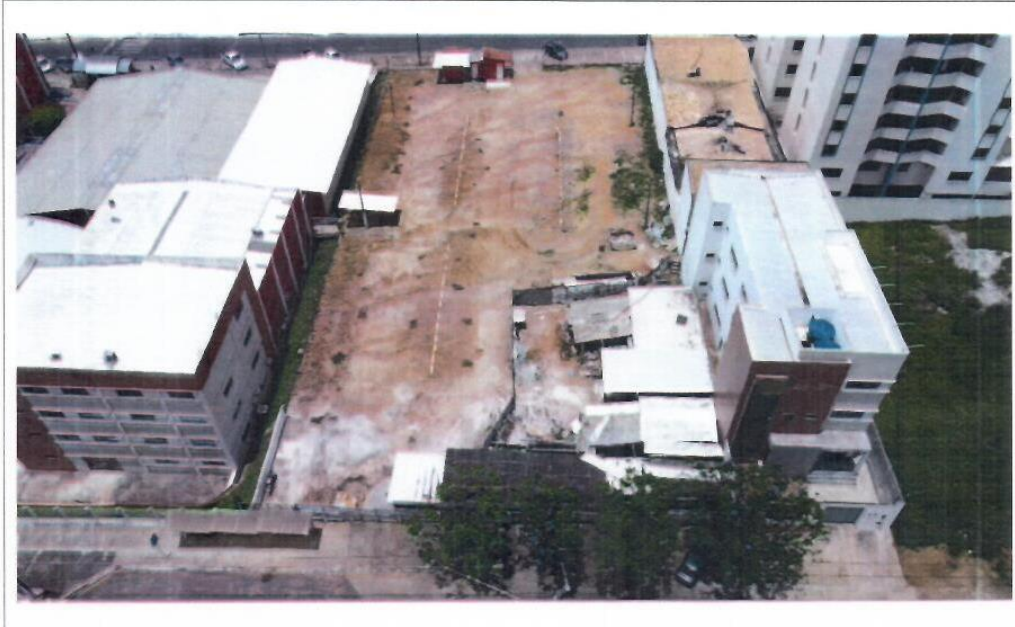
Vista Aérea dos 06 Lotes (Imagem feita com Drone)
