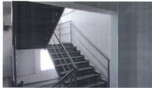
Escada de acesso ao 4º Piso
