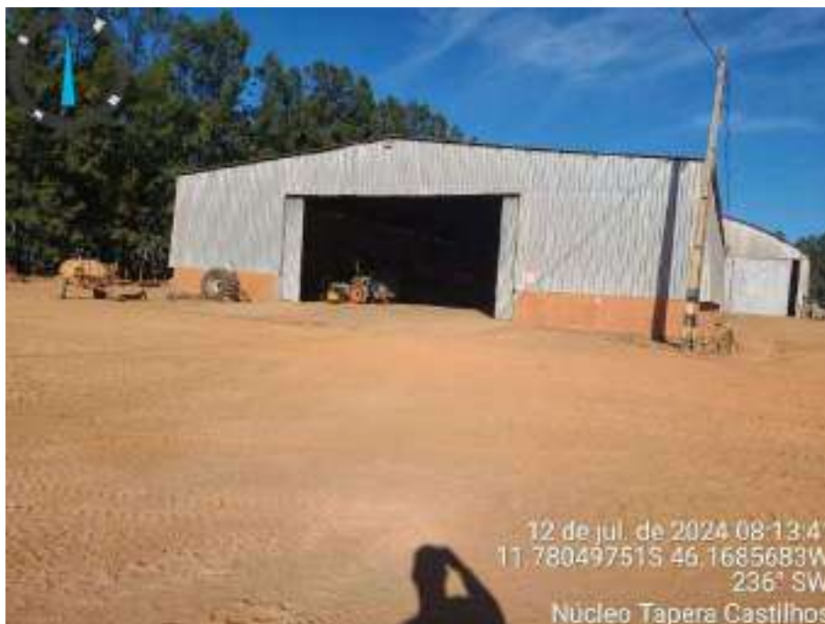
Imagem 9 – Galpão de máquinas
