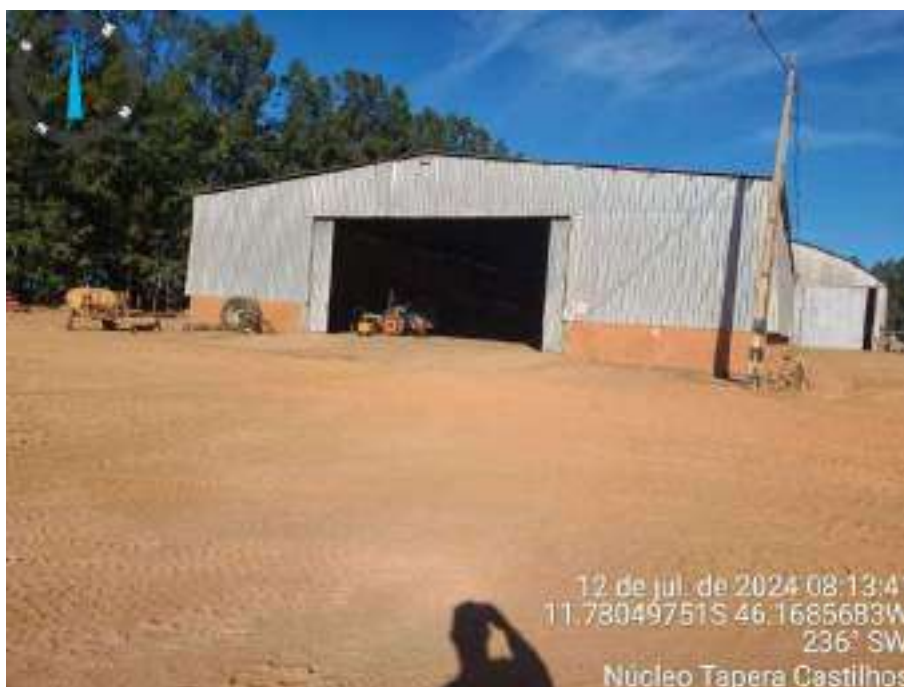
Imagem 9 – Galpão de máquinas
