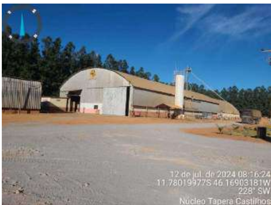
Imagem 6 – Galpão de máquinas.
