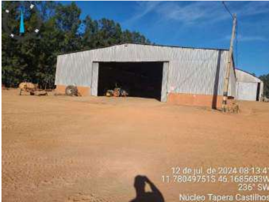
Imagem 9 – Galpão de máquinas
