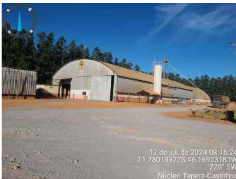
Imagem 6 – Galpão de máquinas.
