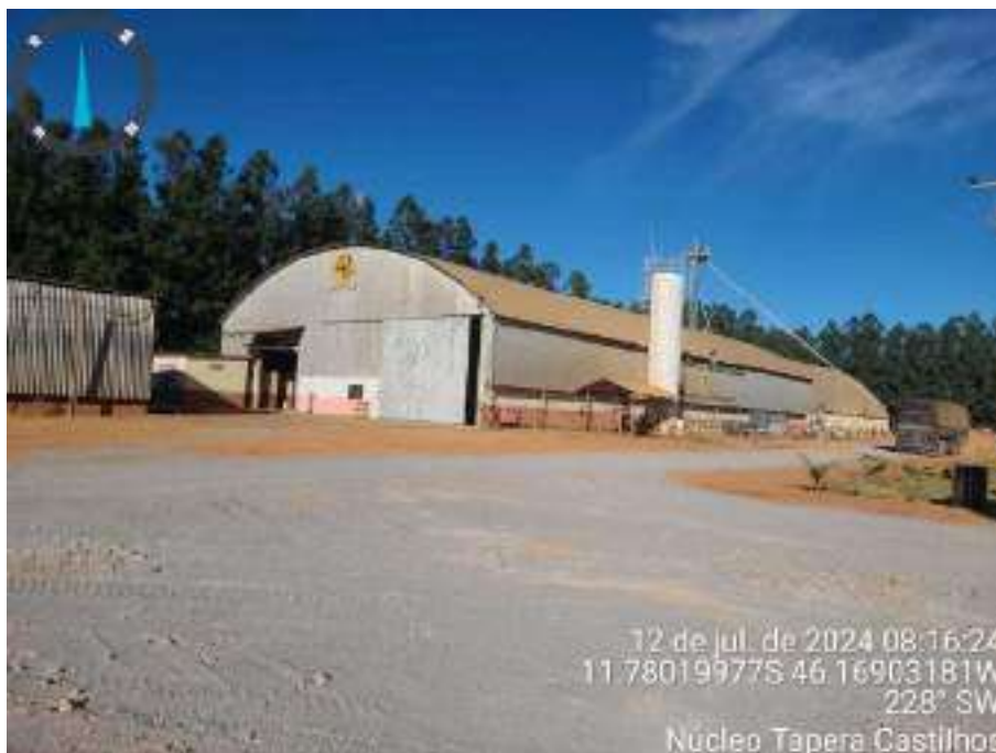
Imagem 6 – Galpão de máquinas.
