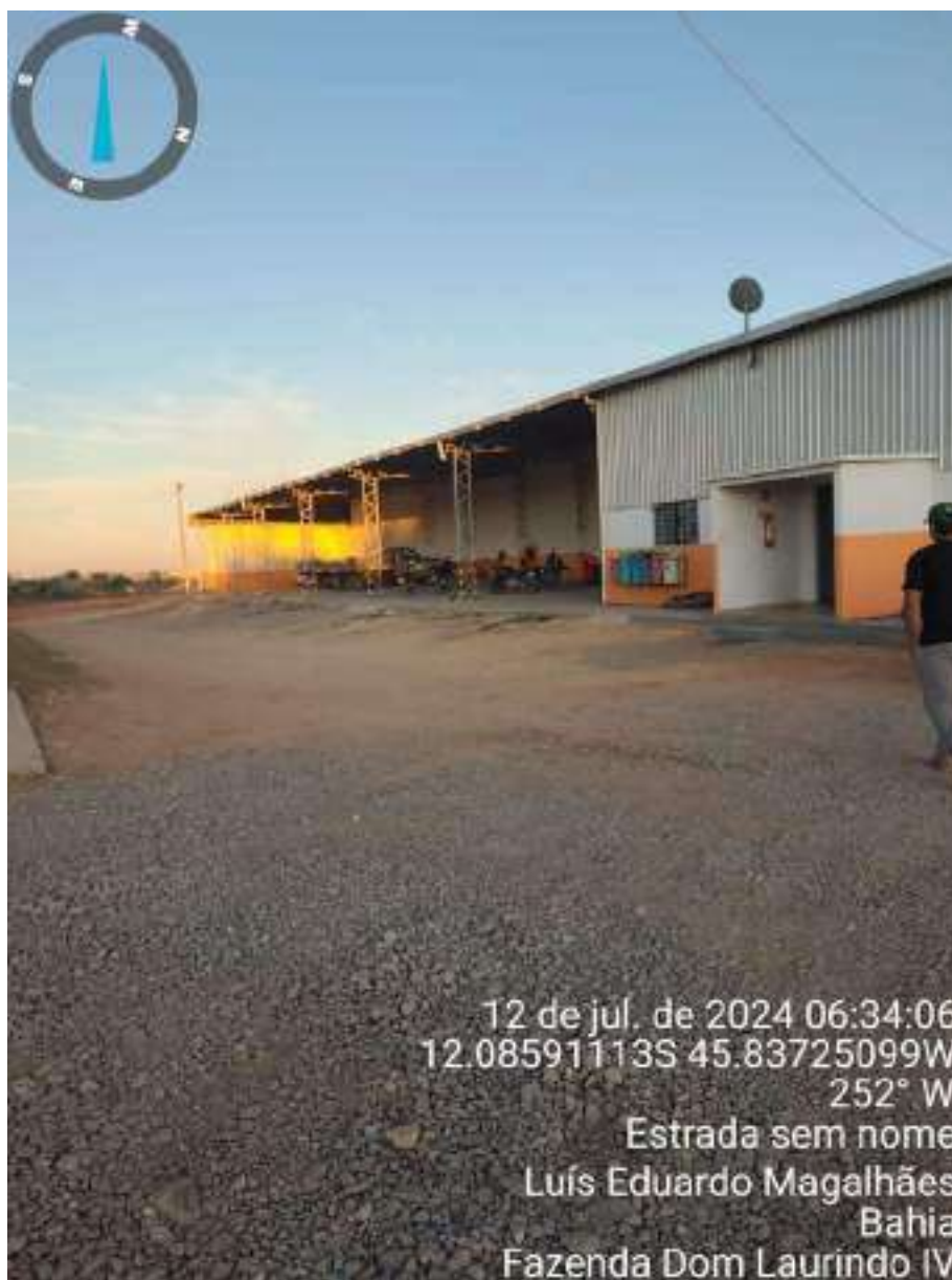
Imagem 8 – Galpão de máquinas e veículos.
