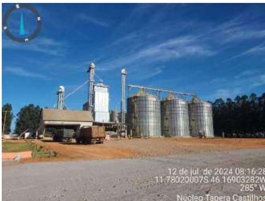
Imagem 5 – Silos secadores e muega para descarga.
