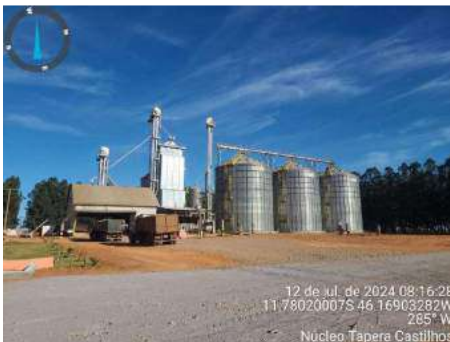
Imagem 5 – Silos secadores e muela para descarga.
