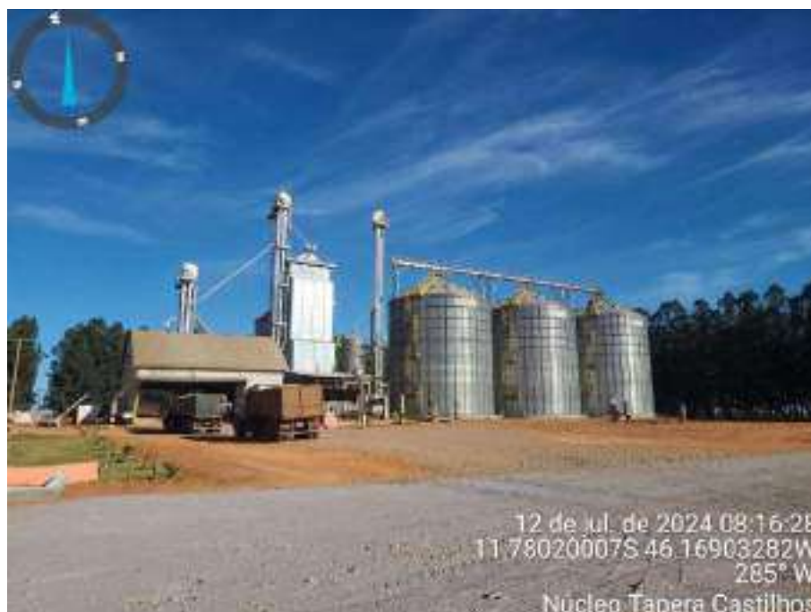
Imagem 5 – Silos secadores e muela para descarga.
