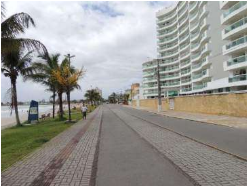
Vistas da testada do imóvel do Edifício Ondas do Mar para a Av. Atlântica. Aspecto para a localização do empreendimento frente à praia de Guaratuba
